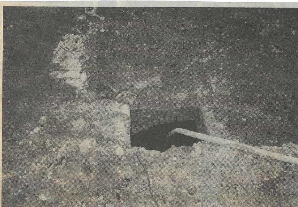
Bij de sloop werd in de molkenkelder een gemetselde regenwaterput gevonden, van binnen afgedekt met groene estrikken en door middel van gele klinkers in toogvorm opgetrokken. (fam. J. de Haas)
